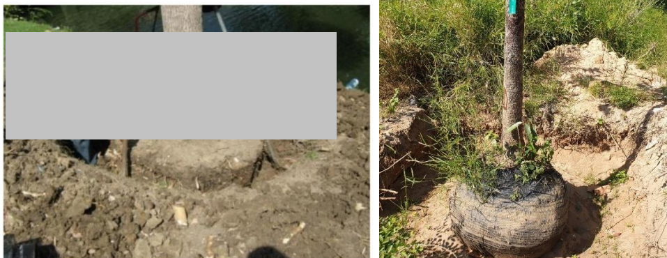
ภาพที่ 6.2-1 ตัวอย่างการขุดดิน ตัดราก และห่อหุ้มต้นไม้เพื่อขุดล้อมต้นไม้ <<กลับไปยังสารบัญ
