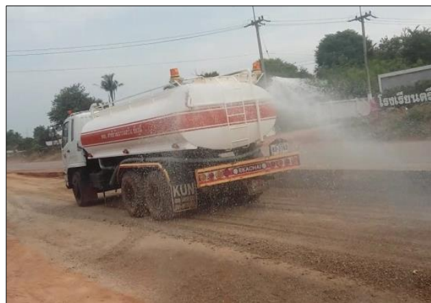
รูปที่ 5.2-11 ตัวอย่างการฉีดพรมน้ำบริเวณพื้นที่ก่อสร้างเพื่อป้องกันการฟุ้งกระจายของฝุ่นละออง
