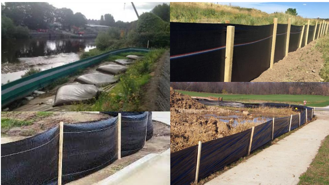
รูปที่ 5.2-7 ตัวอย่างรั้วดักตะกอนชั่วคราวแบบ Temporary Silt Fence <<กลับไปยังสารบัญ
