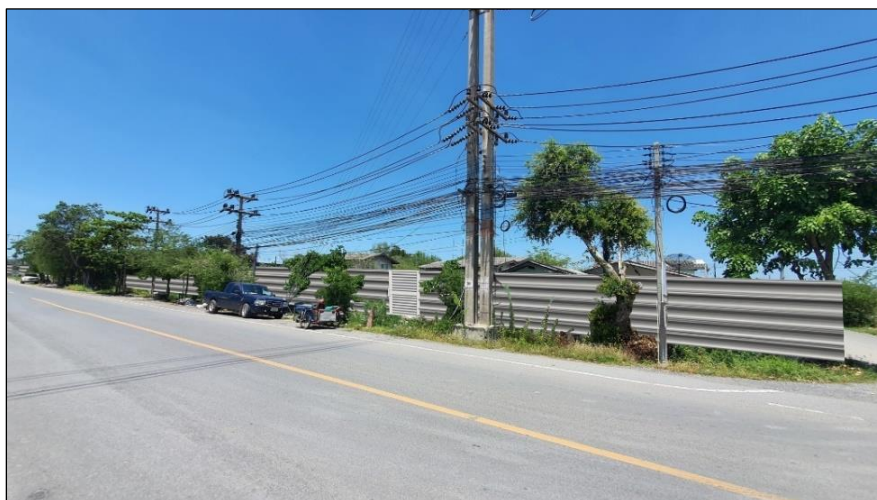
รูปที่ 6.2-10 ตัวอย่างลักษณะการติดตั้งกำแพงกันเสียงชั่วคราว <<กลับไปยังสารบัญ
