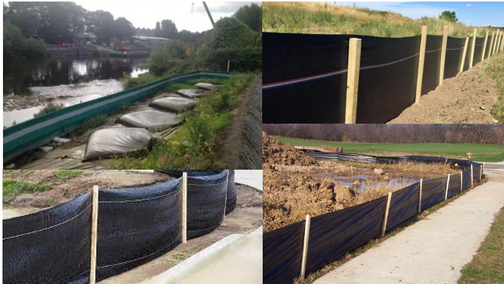
รูปที่ 6.2-4 ตัวอย่างรั้วดักตะกอนชั่วคราวแบบ Temporary Silt Fence <<กลับไปยังสารบัญ
